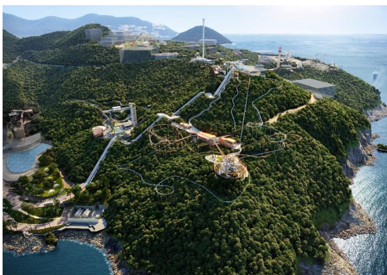
图四：香港海洋公园「历险主题区」体现循环经济理念，将原有过山车设施的圆顶建筑升级改造，融入崭新的高空历险设施。项目不仅实践永续发展，更注入保育元素，让游客在享受刺激体验之余，亦能欣赏港岛南区独有的自然景观。
